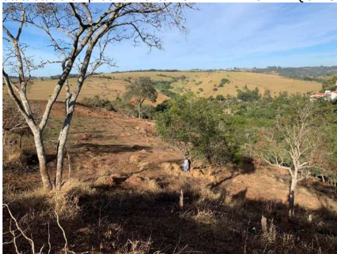
Figura 07: Vista da área do empreendimento LOTEAMENTO PARQUE SANTO ANTÔNIO.
