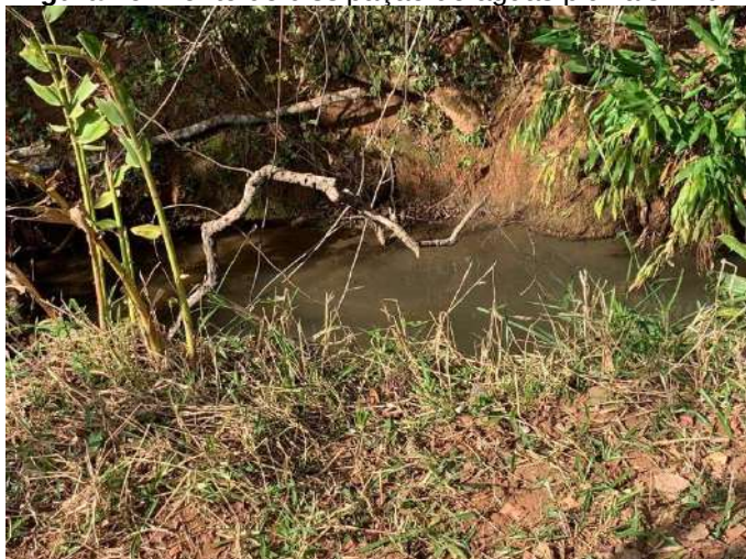
Figura 19: Ponto de dissipação de águas pluviais nº 01.
